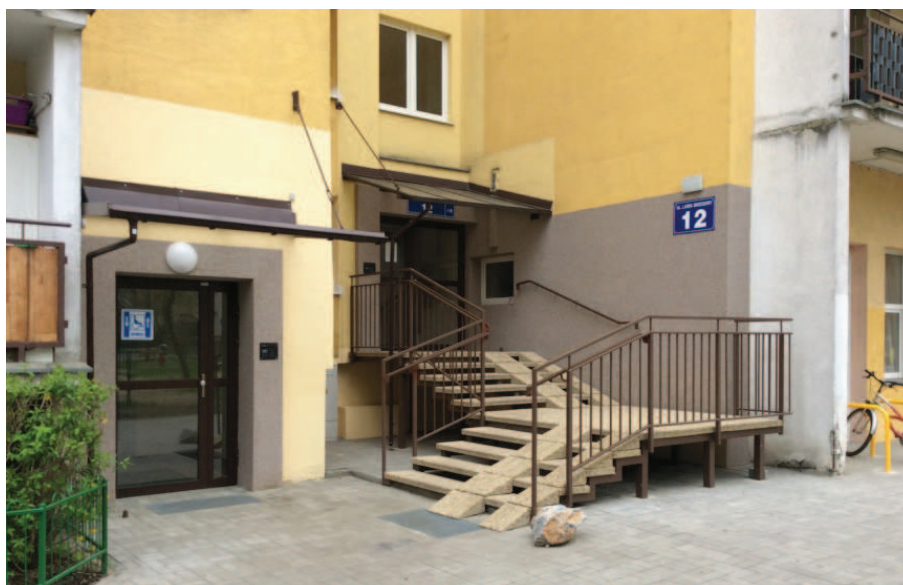
Rys. 17. Przykład wykorzystania komory zsykowej do montażu dźwigu osobowego – umożliwienie swobodnej komunikacji dla osób niepełnosprawnych /źródło: J. Szulc/
