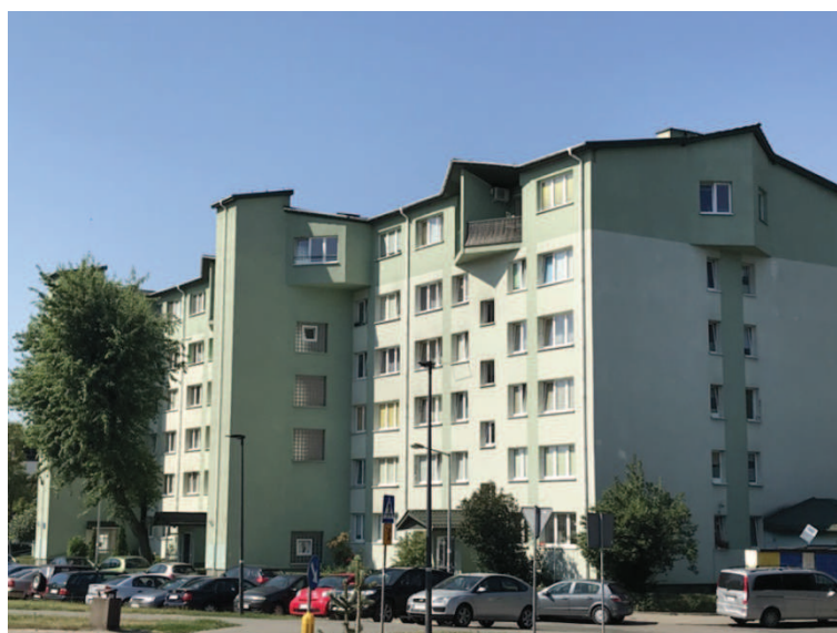
Rys. 18. Przykłady nadbudowy budynków wielkopłytowych i dobudowy zewnętrznych klatek schodowych (z szybami windowymi) /źródło: J. Szulc/
