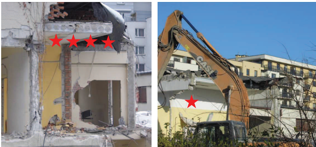
Rys. 3 Przykłady stabilizacji stropów kanałowych i podciągów prefabrykowanych po usunięciu elementów podporowych /źródło: J. Szulc/
